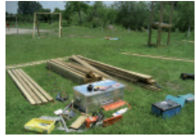
Das Material liegt bereit
